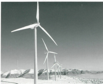
11 Windturbinen erzeugen im Tauern-Windpark in Oberzeiring (A) Strom für 15 000 Haushalte.
