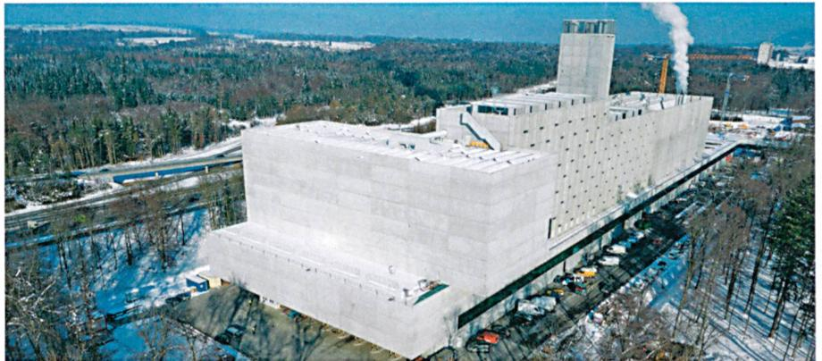
Von aussen sieht die Energiezentrale aus wie ein gewaltiges Containerschiff aus Beton: Zuerst die Kommandobrücke, die eigentlich der Kehrlichtbunker ist. In der Mitte der mächtige Aufbau mit Kamin, der die Kehrlichtverbrennung, das Holzheizkraftwerk sowie das Gas- und Dampf-Kombikraftwerk beherbergt. Und schliesslich der Bug hinten im Bild, in dem das Servicegebäude untergebracht ist. Der Frachter fährt unter der Flagge von Energie Wasser Bern und ist auf Kurs Richtung Atomausstieg.
