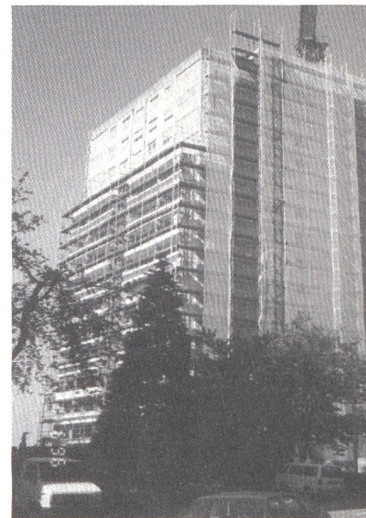
L'immeuble en cours de rénovation, avec ses échafaudages.
