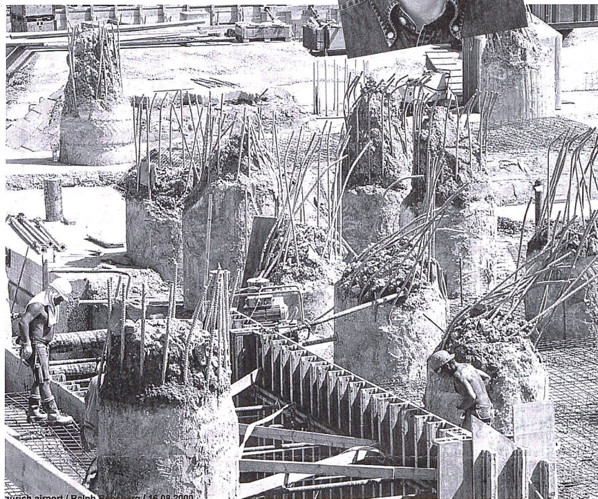
Les pieux énergétiques de l'aéroport zurichoise.
