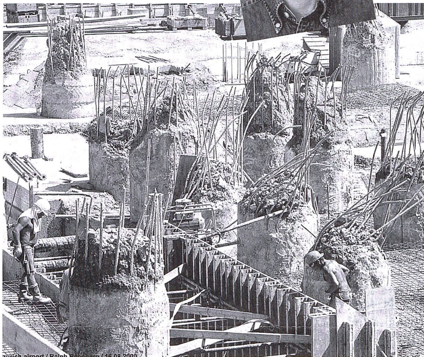
Les pieux énergétiques de l'aéroport zurichoise.
