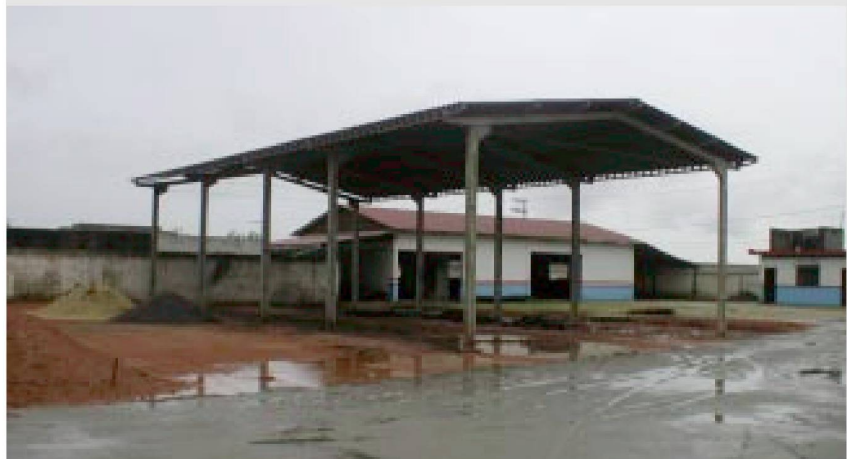
Die neu erstellte Halle im Rohbau
