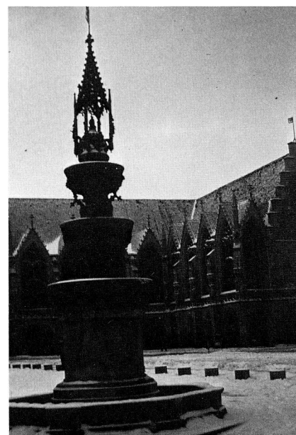
Abb. 3: Marienbrunnen auf dem Altstadtmarkt in Braunschweig – errichtet 1408 aus Bleiguss
