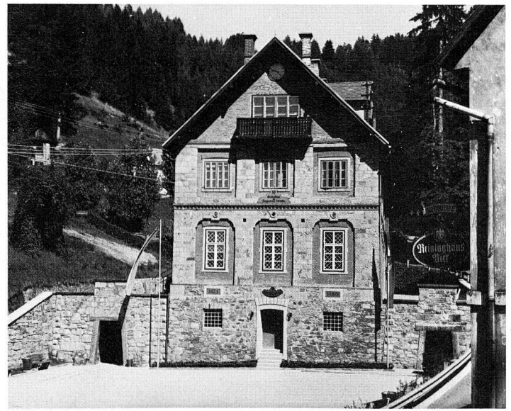
Abb. 2: Grubenhaus (erbaut 1873) neben dem Knappenberger Erbstollen. Im Erdgeschoss seit 1980 Bergbaumuseum Hüttenberg. Foto F.H. Ucik 1982.
