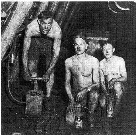
Schiesshauer bei der Zündung einer Serie von Sprengschüssen, 1933
