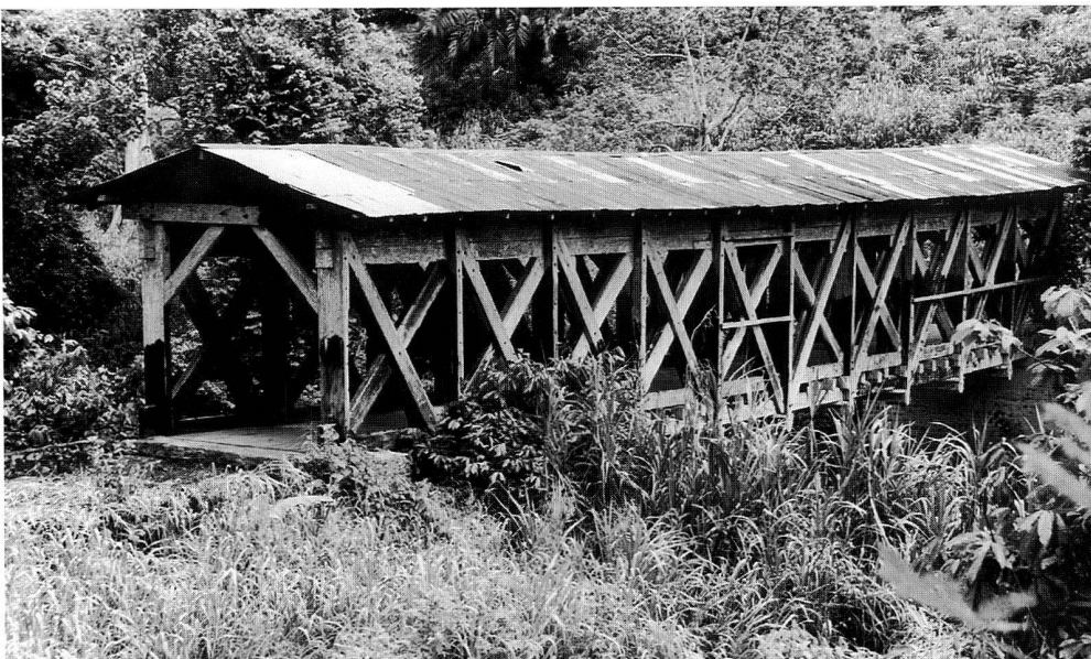
Abb. 7 (Photographin: Polly Hill) Hergebrachte Technik lokal eingesetzt: die gedeckte Brücke zu Mmetiamu in der Nähe von Asboye, Ghana. Ein Basler «Baubruder» aus Andelfingen, Jakob Isliker, wurde 1900 aus der Basler Mission entlassen und lebte nachher in Ghana als unabhängiger building contractor, der Aufträge für einheimische Bauherrschaften übernahm. Hier finanzierte eine sog. Company von einheimischen Kakaobauern den Bau einer Brücke, um ihr Land jenseits des Flusses Densu zu erschliessen. Nach ihren eigenen Unterlagen hat die Company ihr Kapital gut durch Brückenzoll verzinsen können, bis weiter flussab die Regierung eine neue und für Fahrzeuge befahrbare Betonbrücke baute.
