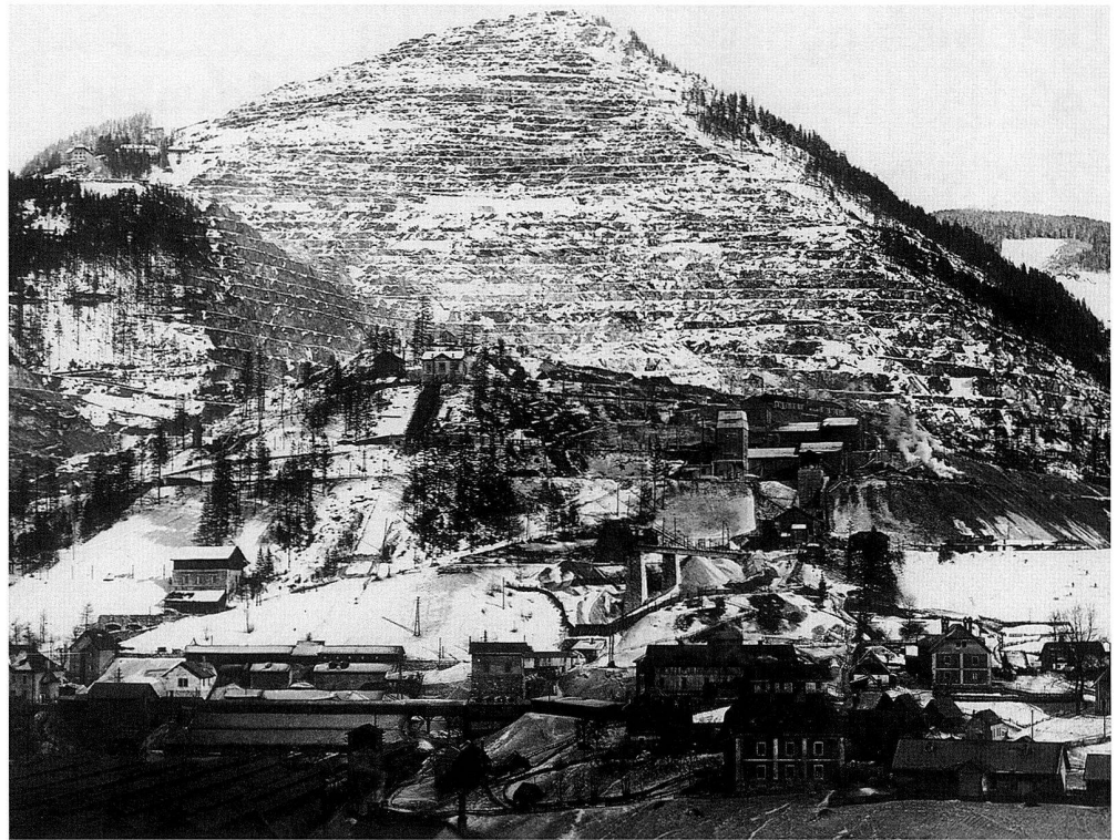
Abb. 2: Der Steirische Erzberg um 1925. Im Vordergrund: Aufbereitungs- und Röstanlagen. – Bildarchiv Köstler, undatierte Fotoreproduktion.
