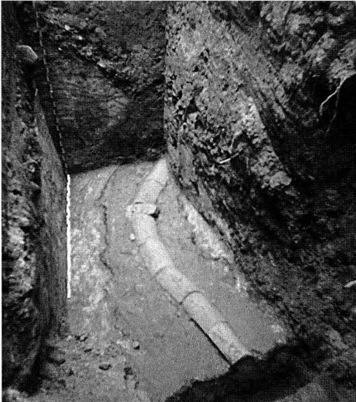
**Bild 11: Drover-Berg-Tunnel bei Düren (Deutschland). Die Wasserleitung knickt aus dem Hangverlauf in den Tunnel ab. (Foto: Klaus Grewe)**
