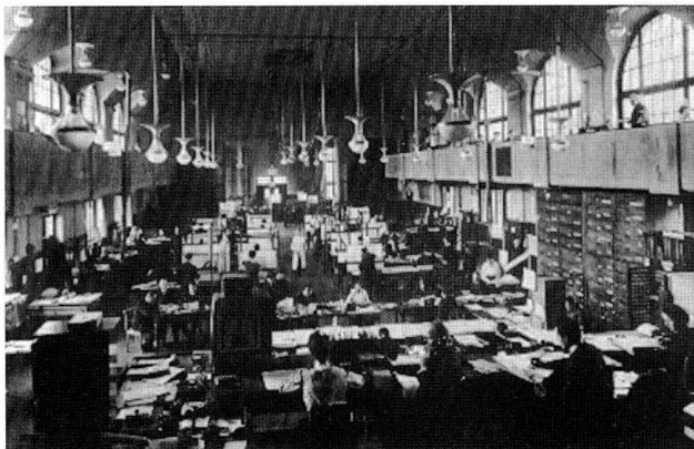
Bild 7: Fabrikationsbüro «Fabo» in Berlin-Spandau.
