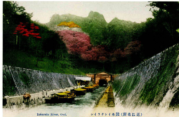
Bild 13: Wasserzuführung zum Kraftwerk Keage in Kyōto: Tunnelengang des Kanals auf der Seite des Biwa-Sees; Entwurf und Bau von Tanabe Sakurō, Absolvent des College of Engineering, fertiggestellt 1890. (Postkarte, Beginn des 20. Jh.)
