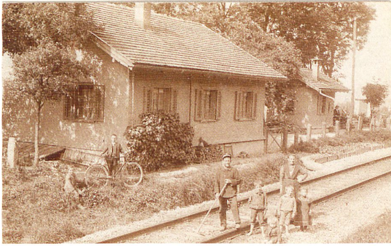
Für die Kontrolle und den Kleinunterhalt des Oberbaus stellten die Bahngesellschaften Bahnwärter an, die entlang der Strecke wohnten. Auf dem Bild der SBB-Streckenwärter Lehmann mit seiner Familie um 1910.
