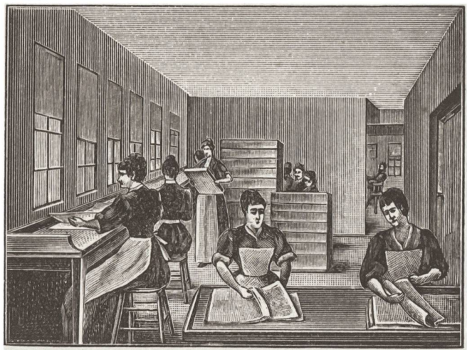
5 Schritte bei der Herstellung von Albumin-Kopierpapier für die Fotografie: Schlagen des Albumins zu Schaum, Tränken des Kopierpapiers mit flüssigem Albumin und Aufhängen zur Trocknung, Satinieren des Albuminpapiers, d.h. Pressen im Kaland, um eine geschlossene, glänzende, glatte Papieroberfläche zu erhalten, und schliesslich Sortieren und Verpacken des handelsfertigen Papiers.
