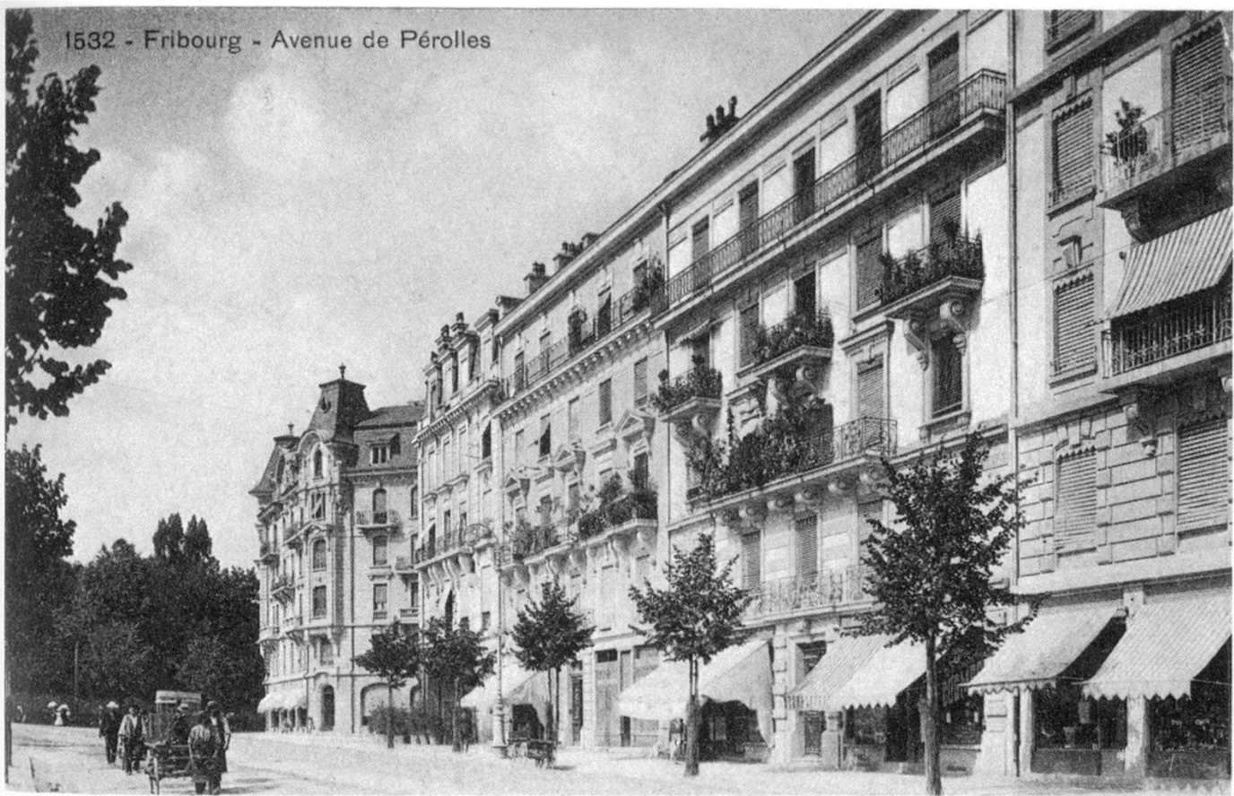
Abb. 1 Geschlossene Bauweise: Historisierende Fassadenflucht mit klassizistischer Instrumentierung. Freiburg, Pérolles, um 1910. – Postkarte.
