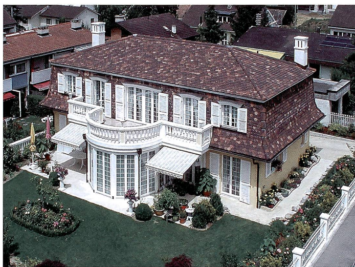
Durch die ungewohnte Perspektive erscheinen die Häuser beinahe dreidimensional. Kabel, Masten und stürzende Linien werden wegretuschiert.
