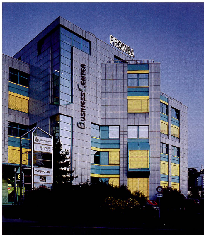
Die Büros der PROMEA befinden sich im Business Center, Schlieren
