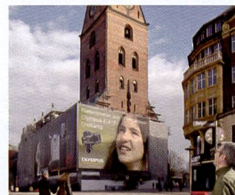
Dieses 352m 2 grosse Gebäudeplakat (22x16 Meter) am Baugerüst der St. Petri-Kirche in Hamburg basiert auf einem 10-Megaapixel-Bild der Olympus E-410.
