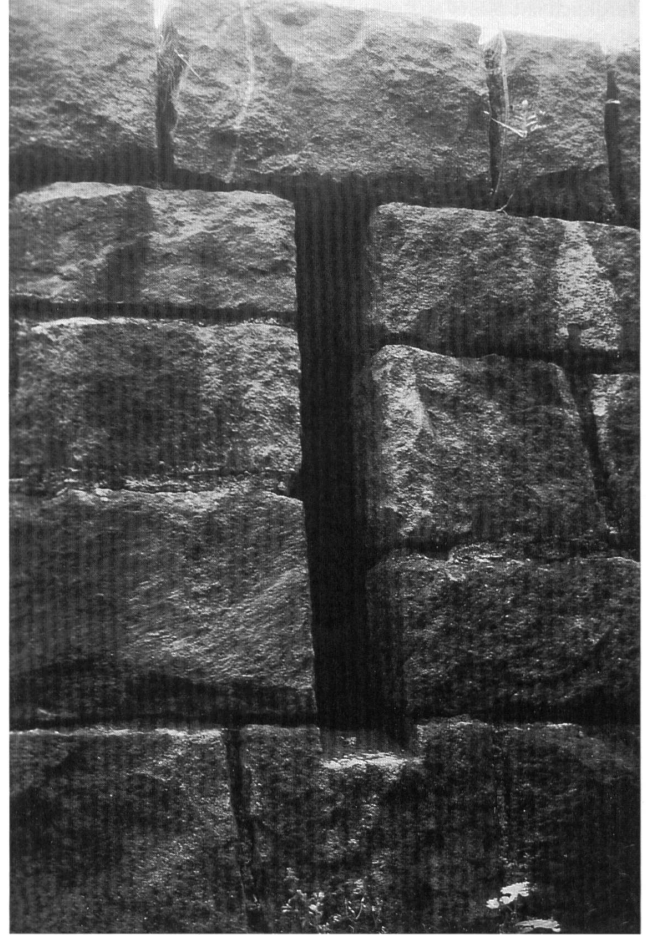
Abb. 13: Fensteröffnung im Rundbau des Schlageter-Denkmals, Aufnahme Fuhrmeister 1996.
