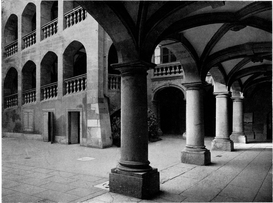
FIG. 220. — Portique et cour de l'Hôtel de Ville.
