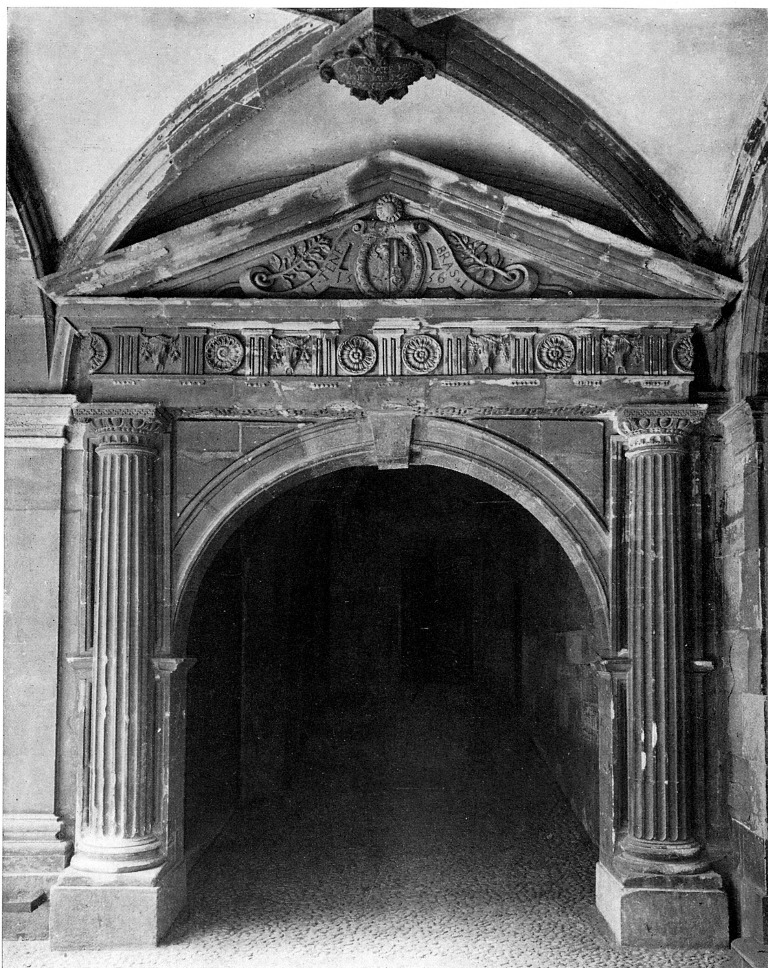
FIG. 216. — Hôtel de Ville, portail de la rampe, 1556.
