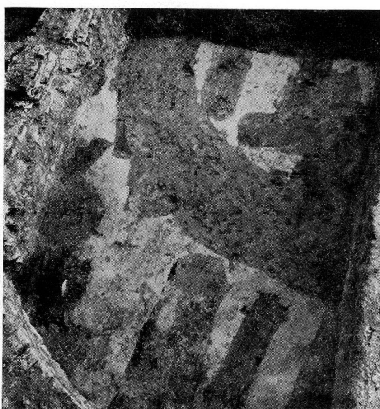
Fig. 3. Trace de la fondation du noyau central (Muizen).
