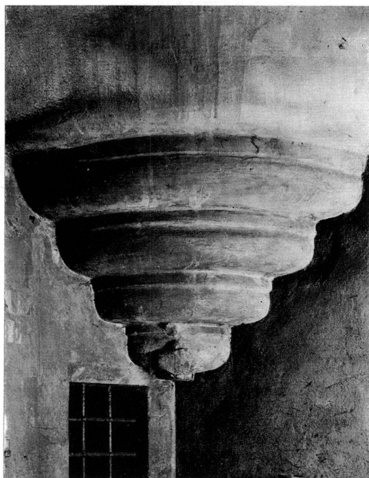
Fig. 12. Base de la Tourelle en encorbellement.
