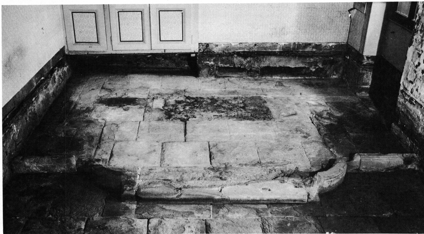
7. Chapelle du résident de France. Vue de la tribune servant de chœur avec, au premier plan, le muret et la marche supportant autrefois une balustrade (photographie Monique Delley).
