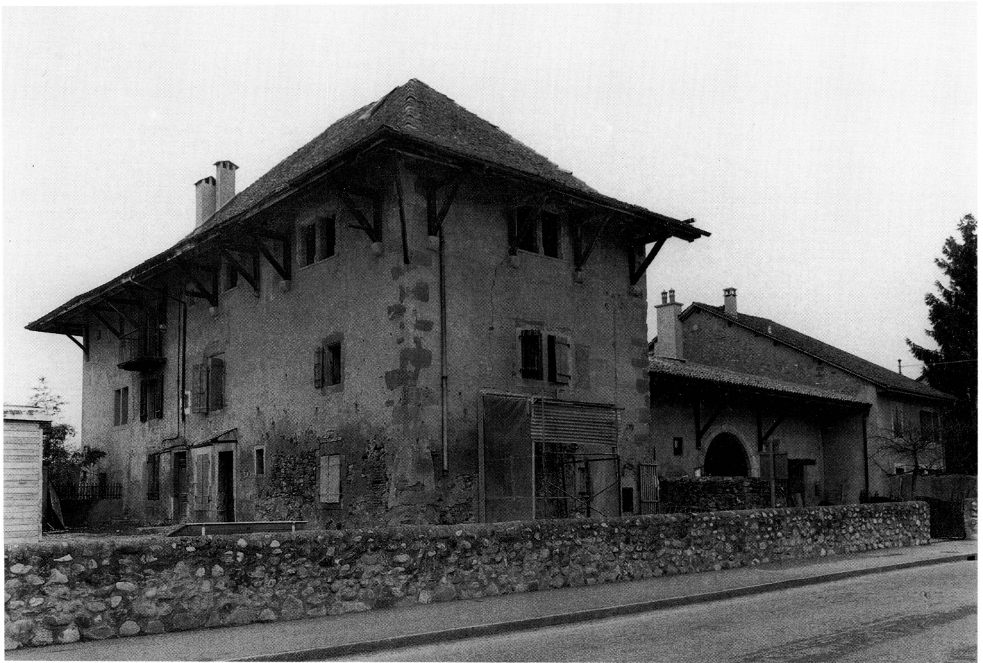
1. Meinier. La maison de La Tour.
