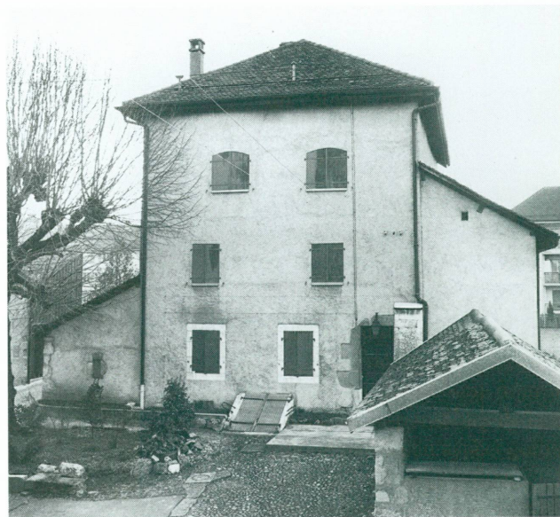
1. La Tour de Meyrin avant la restauration de 1994
