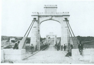
4. Hermann Hug (1825-1888) | Portiques du pont de Peney , 1851-1852 | Les portiques sont les seuls éléments qui ont subsisté de la construction originale après l'éroulement de 1852 (photographie originale d'une collection perdue).
