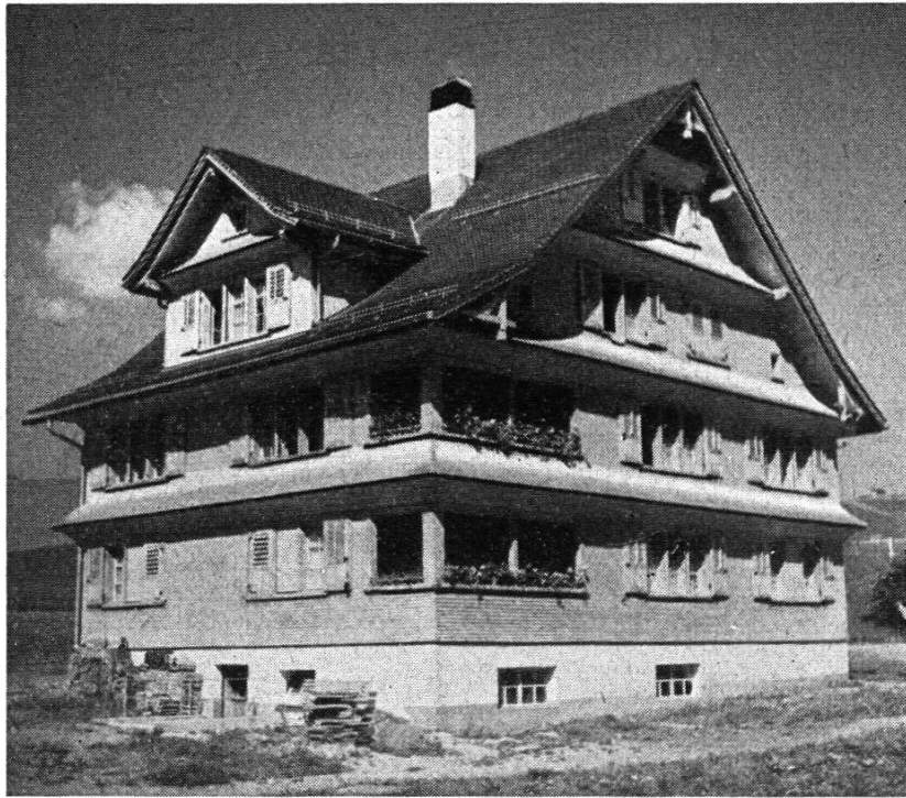
Neues Zweifamilienhaus im Dorfkern.
