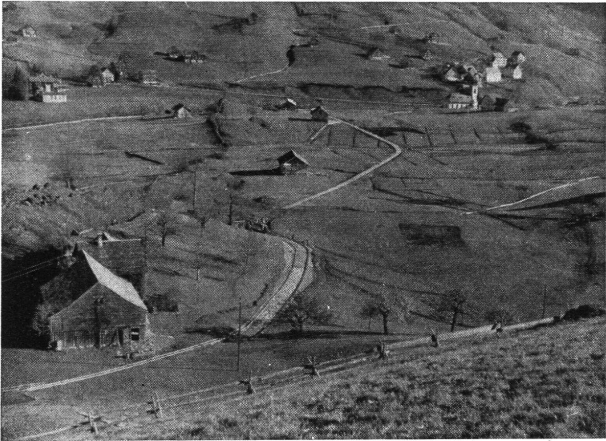
Ein Teil der ausgeführten Entwässerungen und die neue Güterstraße nach Hinterbüel
