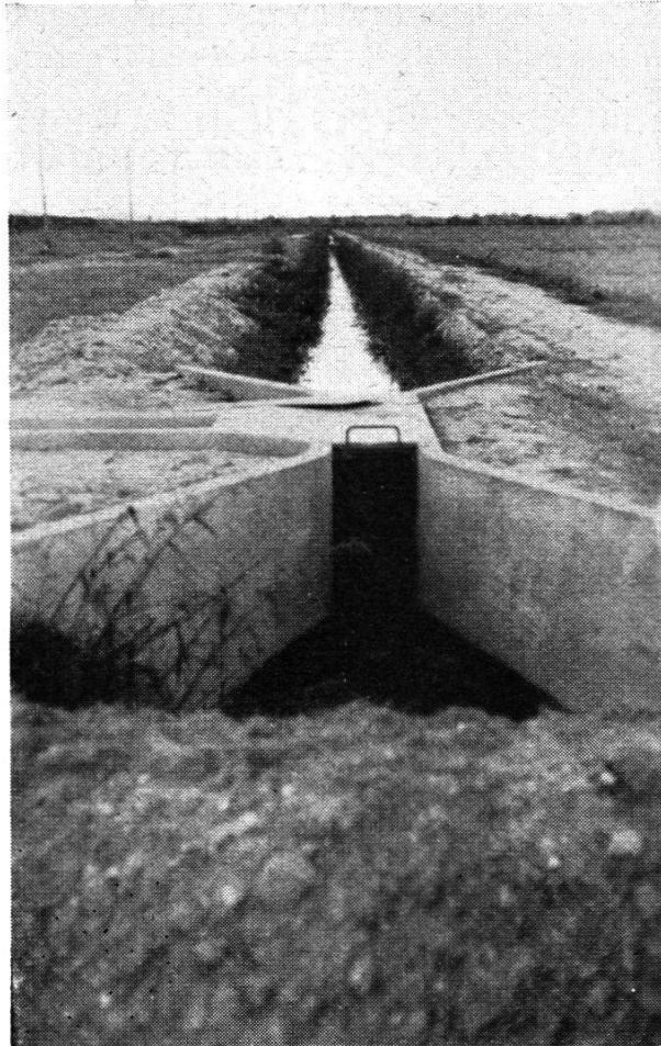
Canal principal de distribution d'eau
