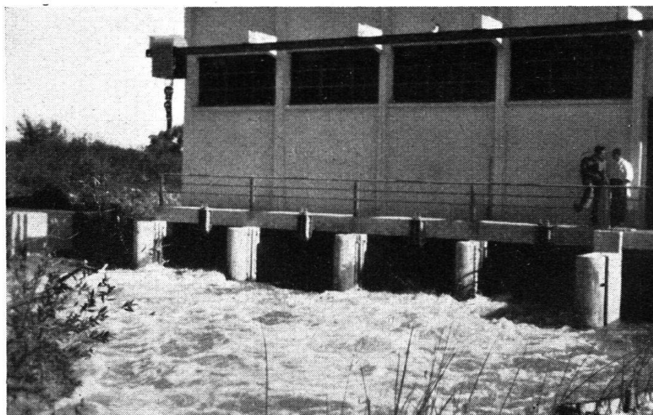
La station de pompage de Pont de Crau côté amont. Le pompage vient de commencer et on observe déjà un abaissement de l'eau de l'émissaire (trait noir sur les piles blanches).
