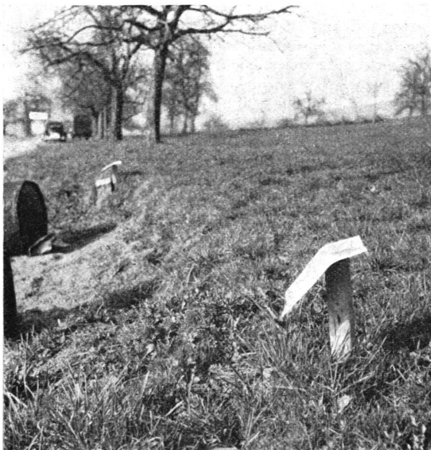
Abb. 2. Exzentrisch angebrachte Signaltafel, ungünstig
