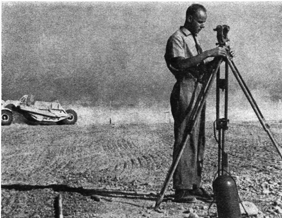
Flugpisten wurden den erhöhten Anforderungen des Düsenluftverkehrs angepasst. Riesige Bauplätze entstanden sozusagen über Nacht. Rasch, zuverlässig und genau mussten Planung und Kontrolle sein, weshalb vorwiegend Wild-Nivelliere und Theodolite zum Einsatz kamen.
