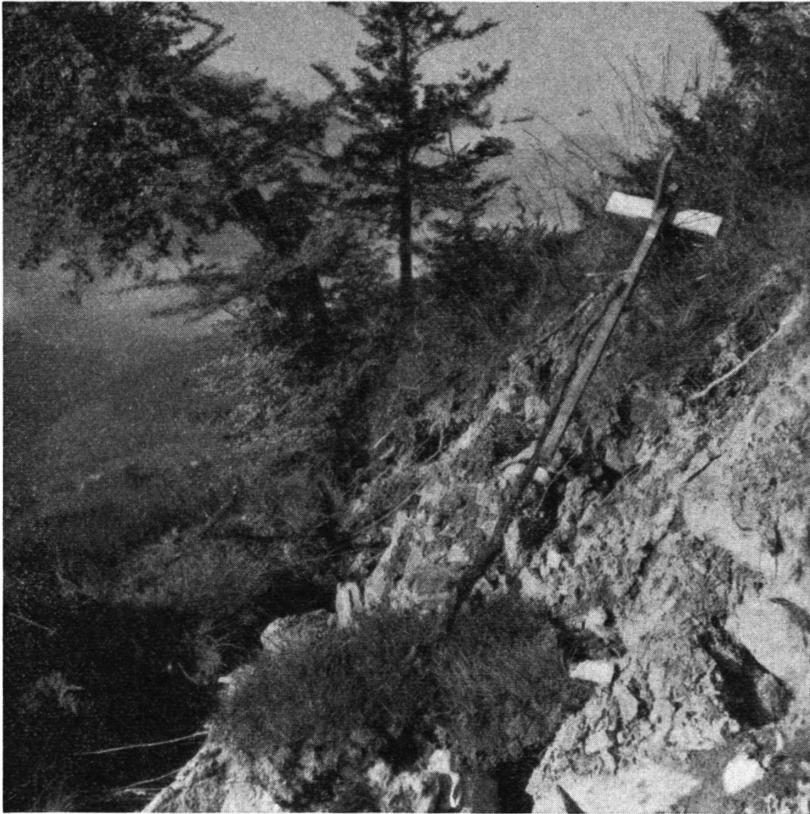
Abb. 4. Aus der Rutschzone von Schuders.
