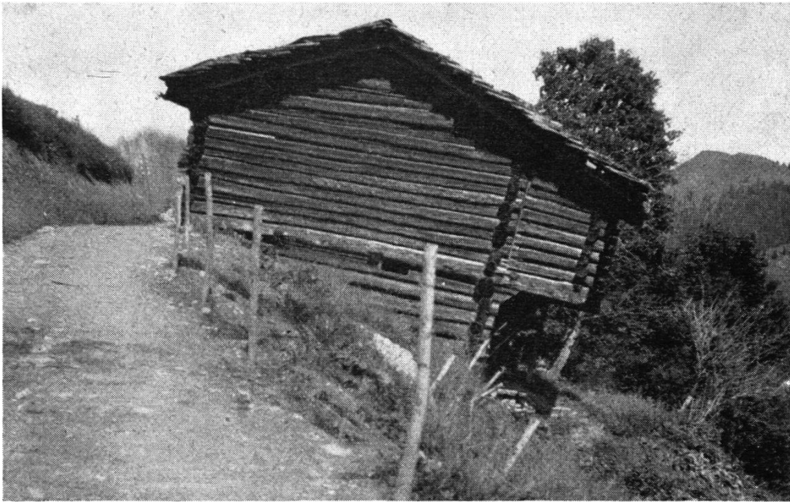
Abb. 3. Aus der Rutschzone von Schuders.
