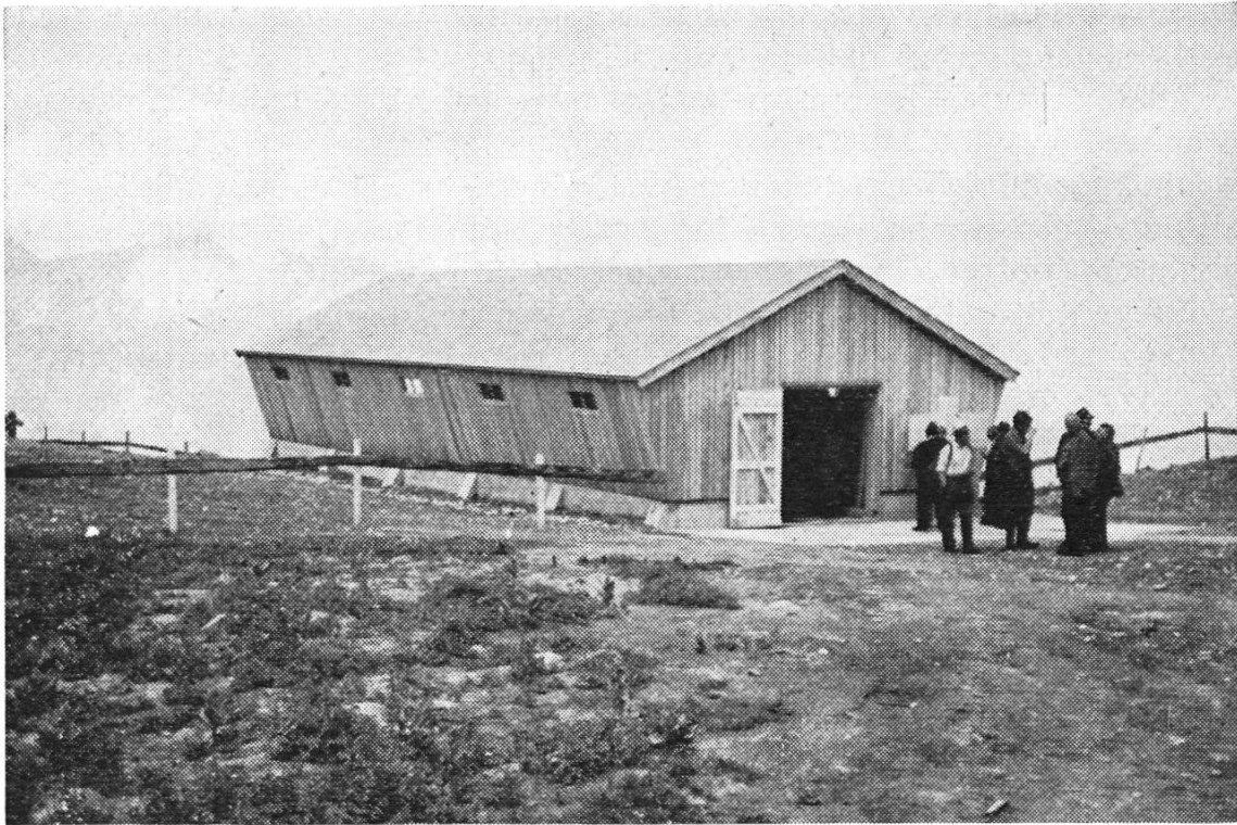
Bild 9 Ansicht des neuen Alpstalles Gaffia, Gemeinde Vilters, 1967. Man beachte die breite Stalltüre, die es ermöglicht, den Stall während des Winters als Remise zu benutzen. Die Fensterluken können entweder offen bleiben, oder es kann ein Glasfenster sowie ein Ladenbrett vor die Öffnung geschoben werden. Es sind keinerlei Beschläge notwendig.
