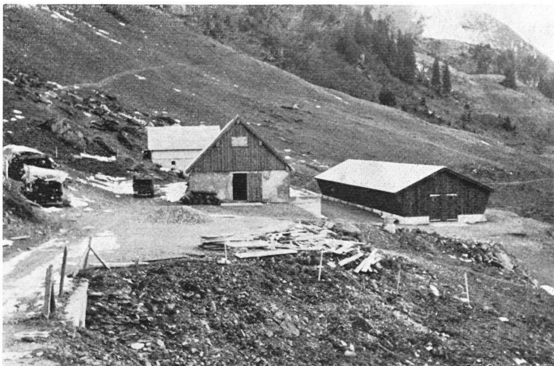
Bild 11 Die Alpgebäude auf Alp Seeben, 1620 m ü.M., Gemeinde Quarten. Links die neue Sennhütte, rechts davon der alte umgebaute Stall und rechts unten der neue Normstall 1967.
