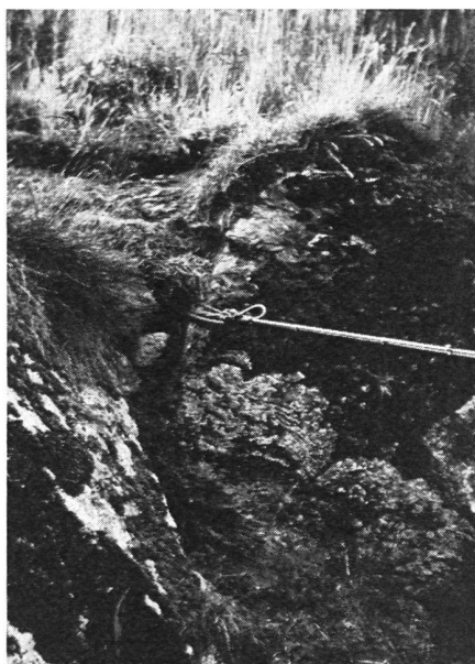
Abb. 9 Führen der Milchleitung, in Zoreseisen verpackt, über eine Feldpartie in St. Martin
