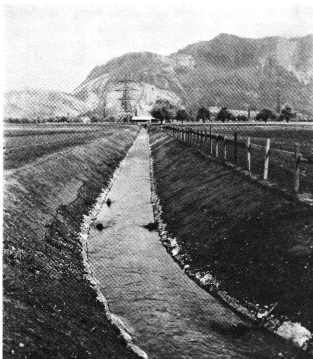
Abb. 8 Naturverbunden ausgebauter Kanal im Meliorationsgebiet der Saarebene. Kiessohle, Natursteinpflasterung und Rasenböschung geben den Fischen Lebensraum und wirken bestimmt nicht störend im Landschaftsbild.
