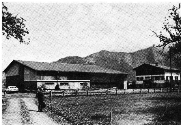
Abb. 3 Neue landwirtschaftliche Siedlung, Typenbau St. Gallen. Sicher eine schöne, moderne Baugruppe, die sich im Landschaftsbild sehen lassen darf. Warum diese Typenbauten nun immer mehr kritisiert werden, ist unerklärlich. Sie wurden entwickelt durch das Architekturbüro Toni Cristuzzi, Widnau, und die Zimmereiunternehmungen Leonhard Lehmann AG, Gossau, und Hans Rutz, Schwarzenbach, unter Mitarbeit des kantonalen Meliorations- und Vermessungsamtes St. Gallen.
