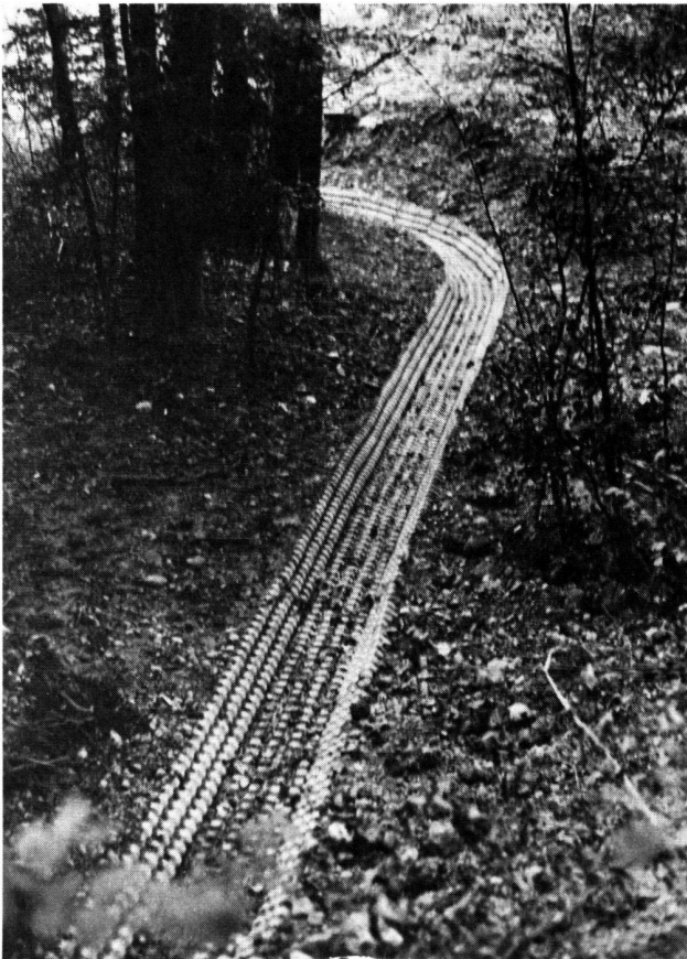
Abb. 2 Gerade verlegt: Noch ist der Beton sichtbar
