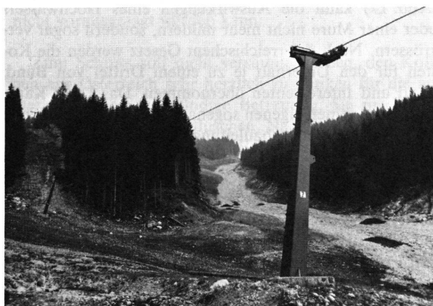
Abb. 16 Auf der breiten Waldschneise der V 73 findet eine starke Flächenerosion statt. Auch die neu herangeführten Humushaufen dürften beim nächsten Starkregen mit viel Wasser und Geschiebe wieder zu Tal befördert werden . . .
