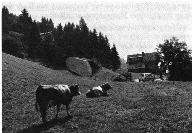
Abb. 11 Der Abweisdamm lenkt die Hochwasser oder Muren des Orterbaches nach rechts auf die Weiden im Vordergrund, so dass er die hangabwärts liegenden Häuser nicht beschädigen kann.
