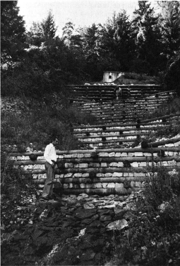
Abb. 4 Diese Runse bei Kras (Drautal bei Villach) wurde gegen Erosion und Rutschung mit Steinkästen verbaut, da das oben sichtbare Reservoir gefährdet war. Die Methode eignet sich in diesem sehr schattigen und feuchten Hang gut.
