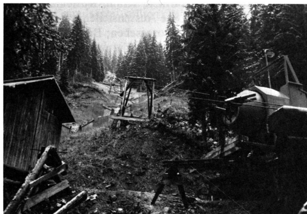
Abb. 2 Typische Wildbachbetonbaustelle auf 1400 m im Mödritschbach bei Irschen im Drautal ( E = 7,7 \text{ km}^2 , Talzuschubprobleme): Links Arbeiterlager, rechts Betonmischer mit dem Beginn der Seilbahn, welche den Beton zur eigentlichen Baustelle hinaufbefördert.
