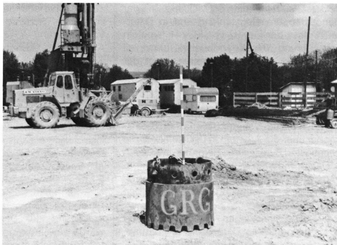
La première couronne de forage est en place.
