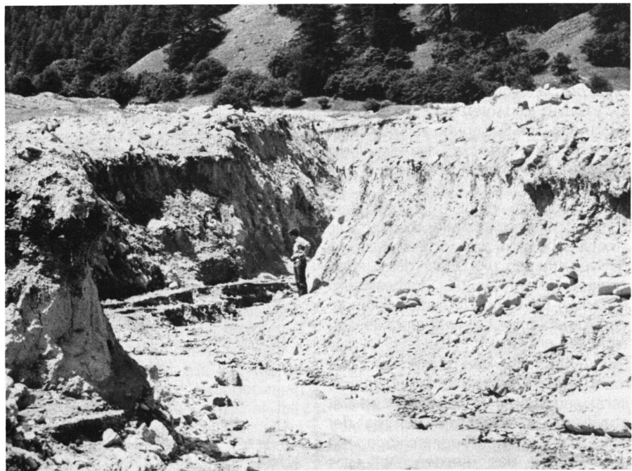
Abb. 3 Drei Hochwasser, grossteils aus Schneeschmelze entstanden, haben ein völlig neues Bachbett im Schwemmkegel ausgehoben. Vallatscha, Münstertal, 1977.
