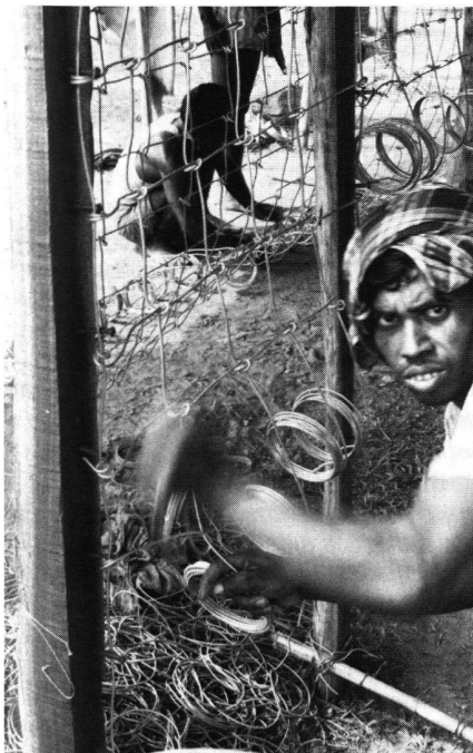
Abb.3 Wildbachverbauung in Nepal: Die benötigten Drahtschotterkörbe werden von ausgebildeten Arbeitern auf der Baustelle hergestellt. Die Topographie erlaubt keinen Strassenbau, und auch eine Seilbahn in die abgelegenen Berggebiete wäre viel zu teuer. Deshalb können keine grösseren Maschinen und nur die notwendigsten Materialien von menschlichen Trägern in oft tagelangen Märschen herbeigeschafft werden.
