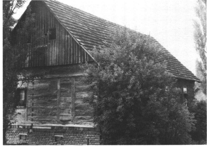
Abb.10 In der Ebene der Save findet man massive Häuser in kleinen Dörfern, die aus Eichenbalken gebaut worden sind. Hier waren früher ausgedehnte Eichenwälder. Es mag ungefähr so ausgesehen haben, wie nach der Eiszeit im St. Galler Rheintal, wo sich der grosse Eichenwald, der sogenannte Arboner Forst, bis hinauf in den heutigen Kanton Graubünden ausgedehnt hat. Auf vielen Gebäuden gibt es noch Storchennester.
