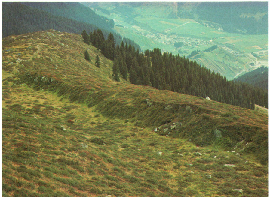
Abb. 5 Eine grosse Verwerfung W der Val Auletta (NW Disentis) ist fast vollständig von Schutt bedeckt. Nur an wenigen Stellen ist noch der anstehende Fels sichtbar.
