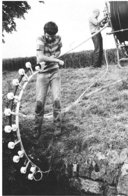
Abb. 2 Reinigung eines Sammlers vom Vorfluter aus.
