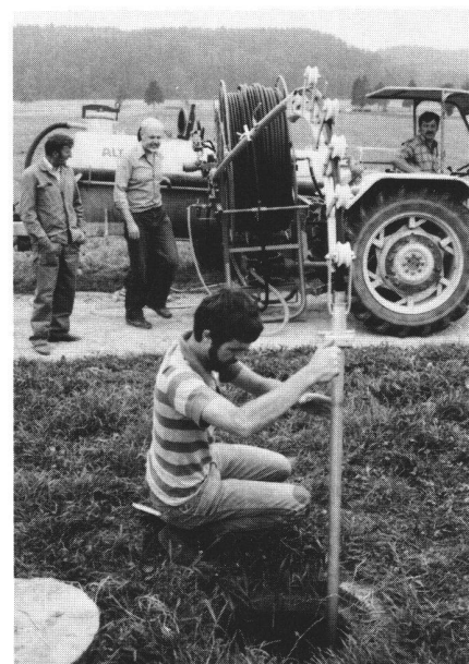
Abb.1 Drainspülung über einen Schacht im Feld. Das Spülwasser stammt aus dem Druckfass im Hintergrund.
