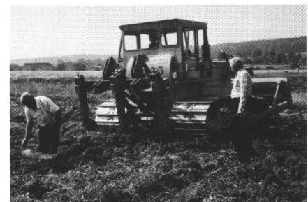
Abb. 3 Cat. D6 C beim Lockern der Versuchsfelder.
