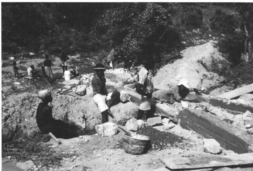
Abb. 2: Bau einer Wasserfassung bei Jean Rabel, Haiti.
