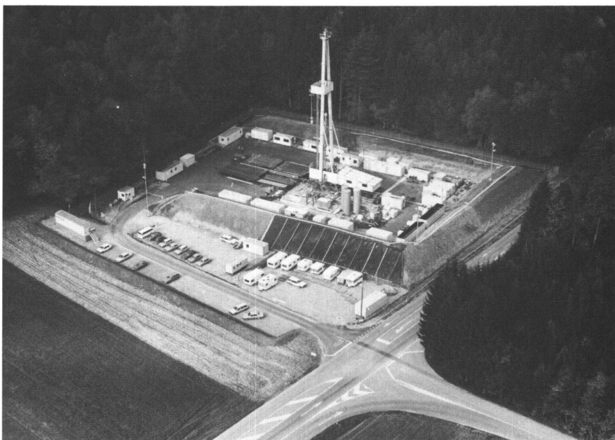
Abb. 1: Werkplatz in Böttstein AG. Hier hat die Nagra ihre erste Tiefbohrung abgeteuft.
