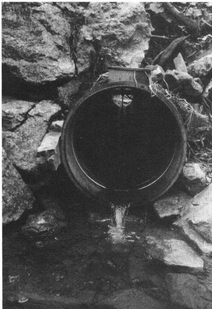
Abb. 2: Auslauf des Strassendurchlass-Rohres (8). Im Rohrinne ist der Schwenkarm des Mess-Schwimmers (9) zu erkennen.
