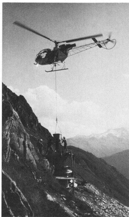
Abb. 14: 400-kV-Mast, Lukmanierleitung, Fundamentbau
