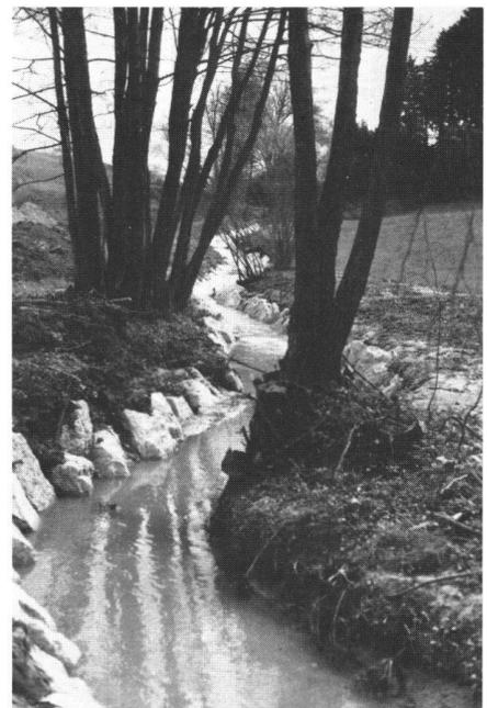
**Abb. 3: Naturnahe Verbauung des Schmiedenbaches im Rahmen der Gesamtmelioration Grosseaffoltern, Gemeinde Grosseaffoltern/BE. Soweit als möglich werden nur die Aussenkurven mit Jurakalkblöcken gesichert und die vorhandene Bestockung belassen (Foto 11.4.1985, KMA Bern).**
