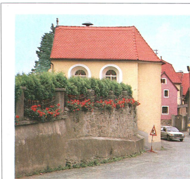
Die alte schadensanfällige, erneuerungsbedürftige Mauer bei der Friedhofskapelle . . .
